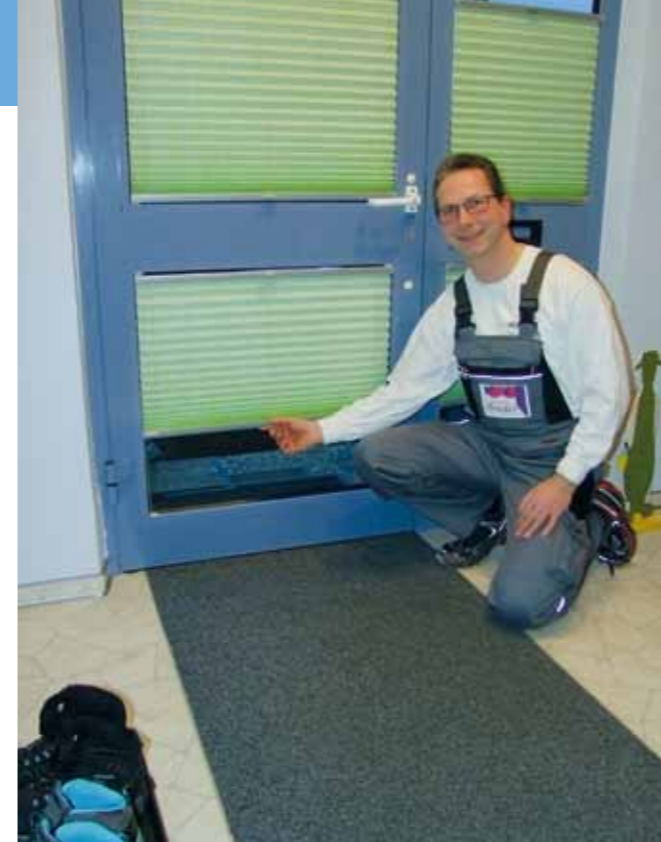
Sauberlaufzone und Plissee-Sonnenschutz im Eingangsbereich
