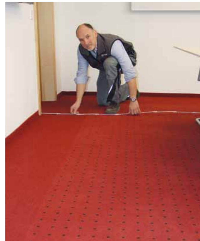
Klaus Riekert verlegt einen roten Veloursteppich mit Intarsien und umlaufendem unifarbenen Fries.
