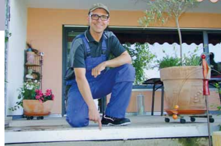
Kay Haug brachte feuerverzinkte Stahlwinkel an die Terrasse an.
