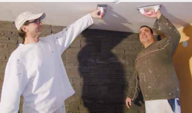
Harzer GmbH übernimmt die Putzarbeiten.
