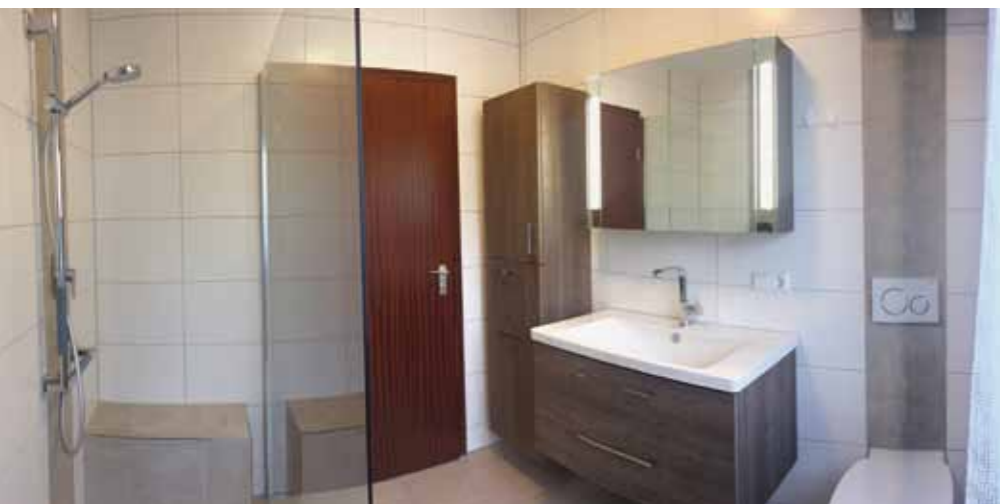
Auf engem Raum großzügig gestaltet: neues Bad ...
